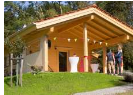
Naturkindergarten in Rohrdorf
